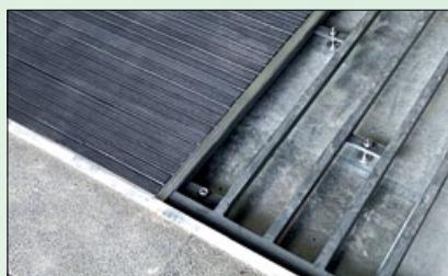
Грязезащитные покрытия из алюминиевого профиля устанавливаются в приямки (специальные углубления в полу) для удобства движения потока посетителей и уборки мусора из под покрытия. Приямки изготавливаются не только со стороны улицы, но и тамбура. Если приямок не был запланирован на стадии строительства здания, то все работы по его изготовлению может выполнить наша компания.
